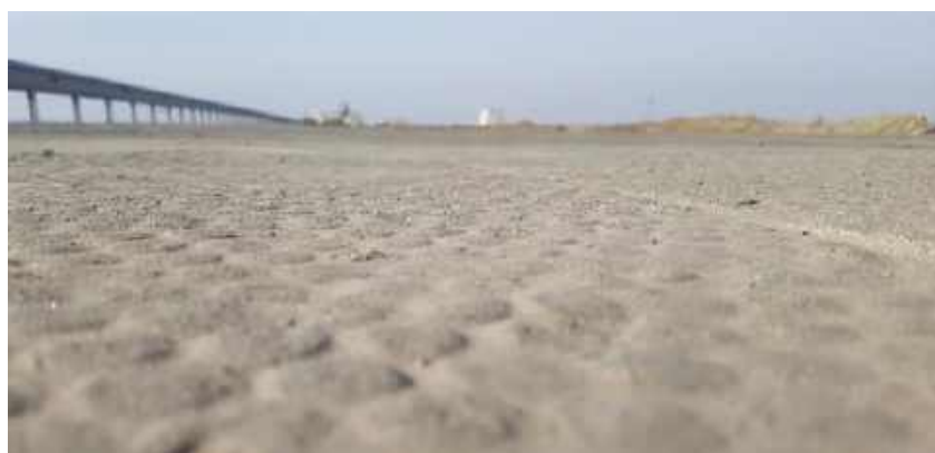
Рисунок 12 – Рифленое улучшенное цементобетонное покрытие на автодороге Кызылорда – Павлодар – Успенка – граница РФ, км 1251
