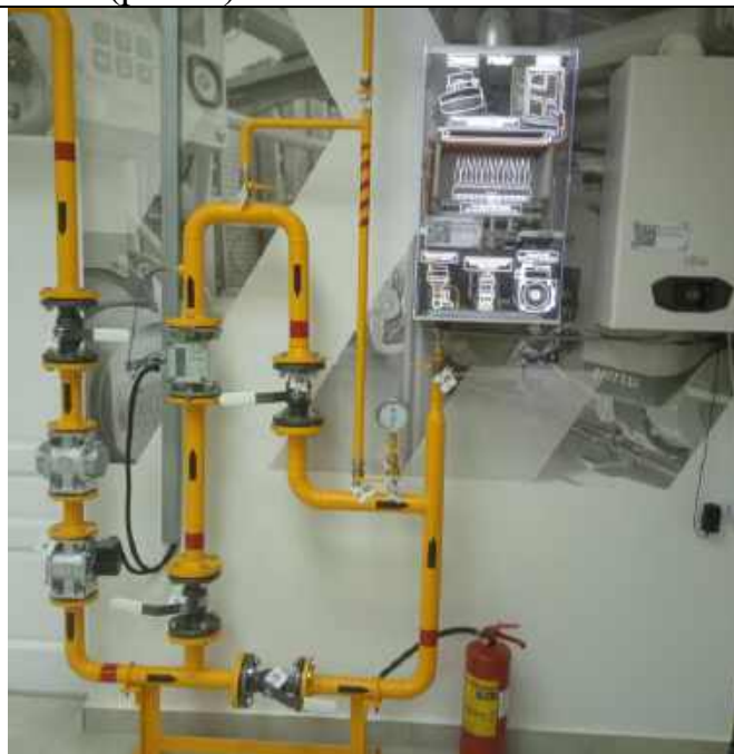
Рисунок 6 –Стенд с подключением коммунально-бытового потребителя
