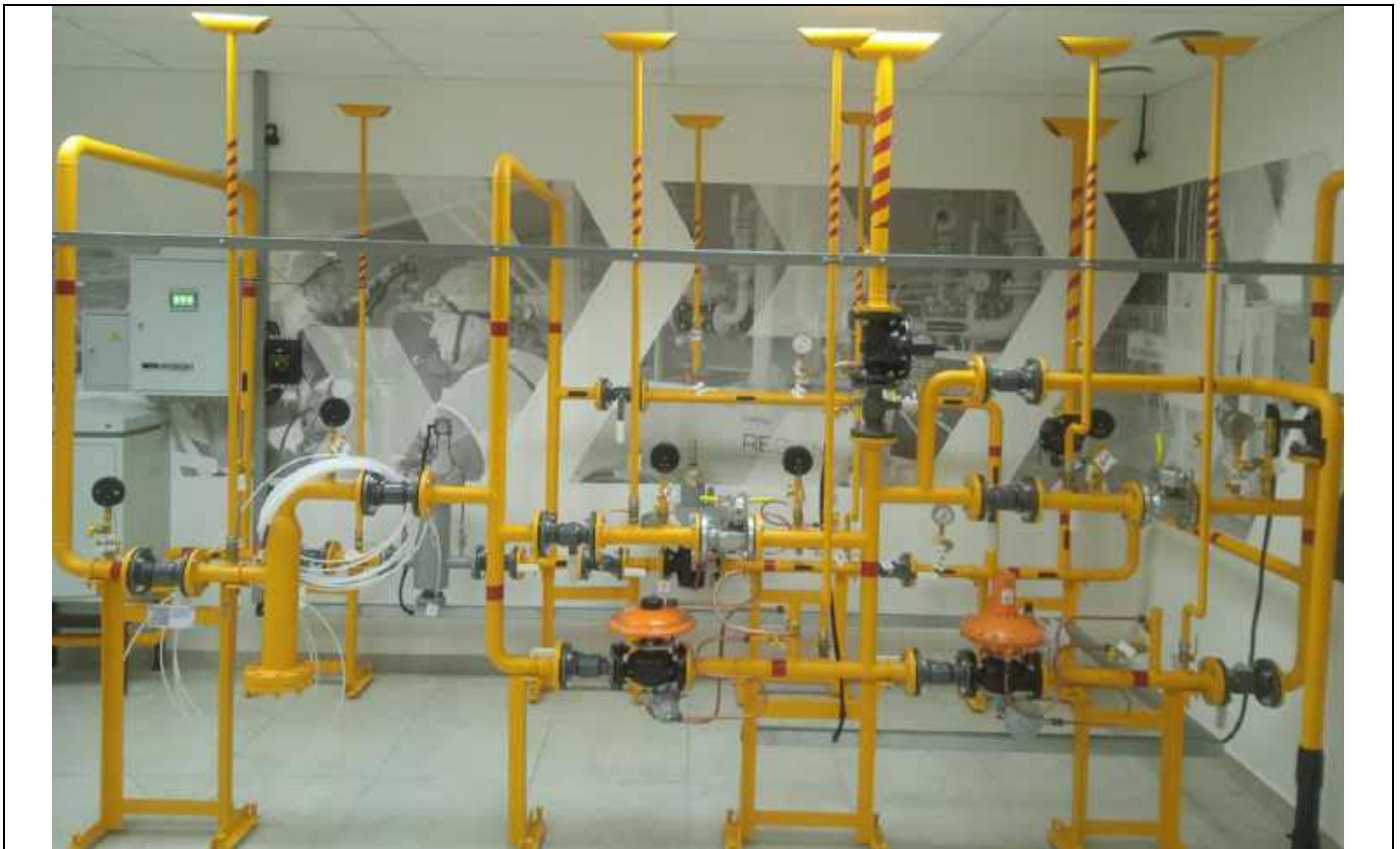
Рисунок 2 – Газорегуляторная установка
