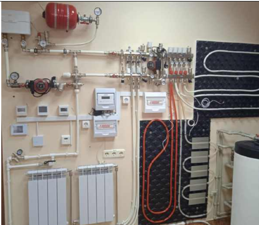
Рисунок 17 – Комбинированная автоматизированная система отопления VALTEC
