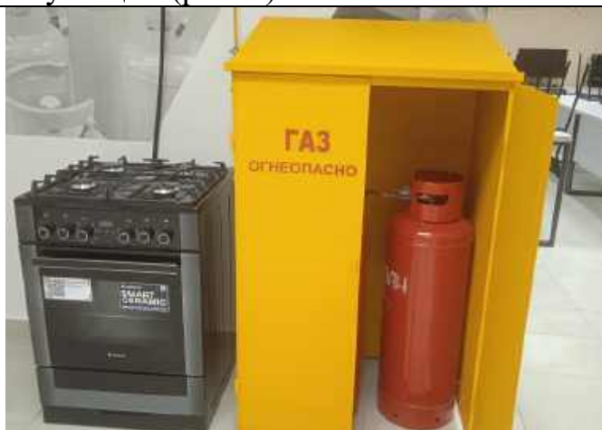
Рисунок 7 – Индивидуальная газобаллонная установка
